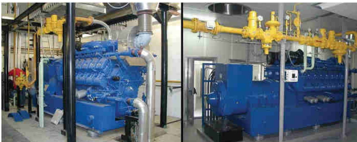
Figura 8: Foto de um motor de combustão interna operando num sistema de cogeração Fonte: França Junior (2006)
