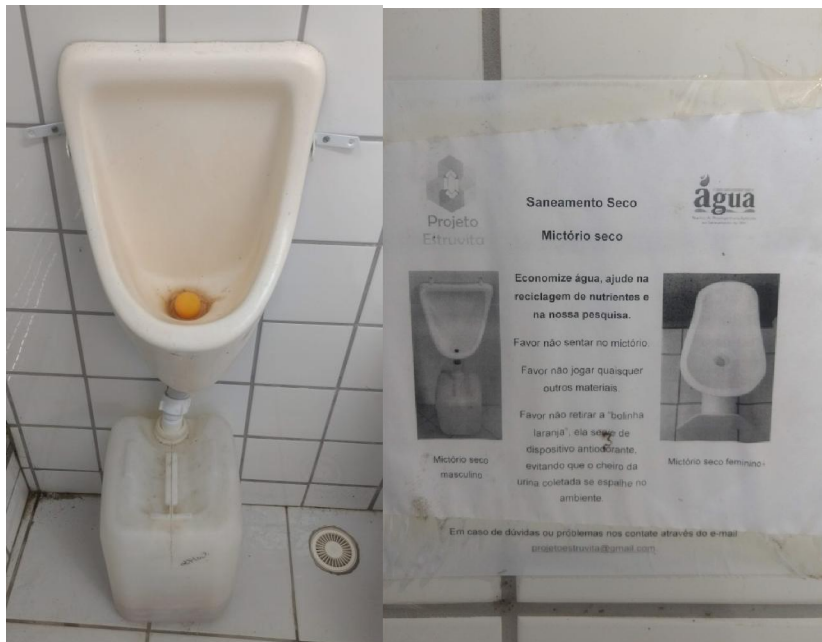
Figura 15 - Mictório seco masculino (esquerda) e cartaz informativo a cerca do uso dos mictórios secos (direita)
