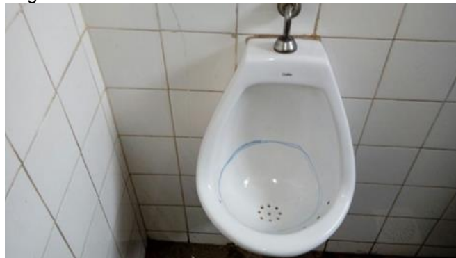
Figura 17 – Mictório: método da Caneta
