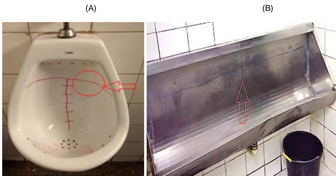
(A) Mictório do banheiro masculino do terceiro andar; (B) Mictório do banheiro masculino do primeiro andar.
