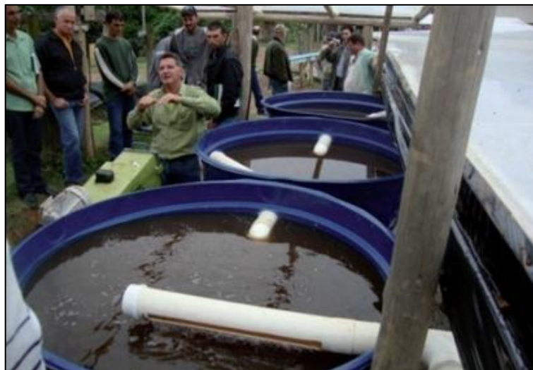
Figura 5 - Caixas de decantação de sistema de limpeza de águas residuárias.
